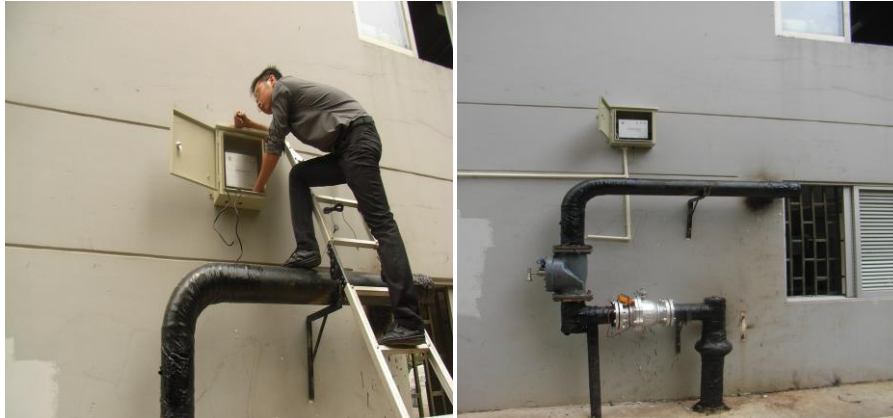
图 11.2 系统在云南省燃气管线地震紧急处置项目中的实际应用
